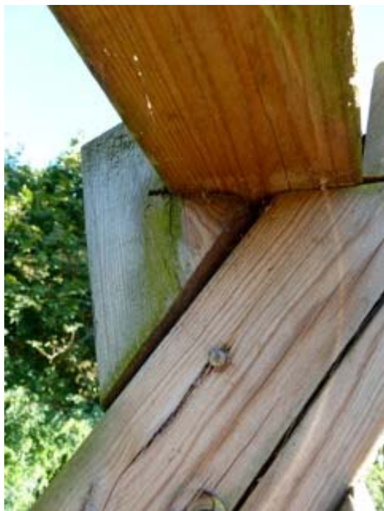
Gyngestativ: Bærende sammenføjninger begynder at give efter
