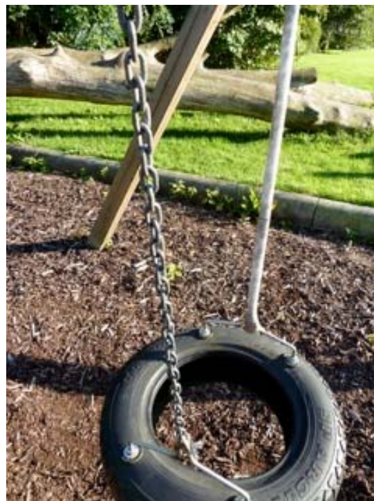
Slange der skal beskytte fingre mod klem-skader mangler. Flosset stålwire ved området omkring holdepunkt.
